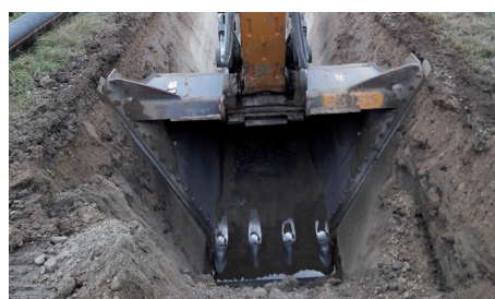
GPS gesteuerte Baggerschaufel
