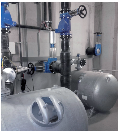
Druckkessel Pneumatik
