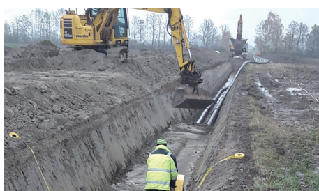
Verfüllen der Künette, Verlegung Warnband
