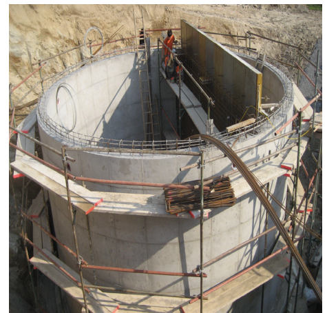
Betonieren des Belebungsbeckens
