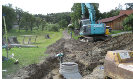
Errichtung des Schmutzwasserkanals
