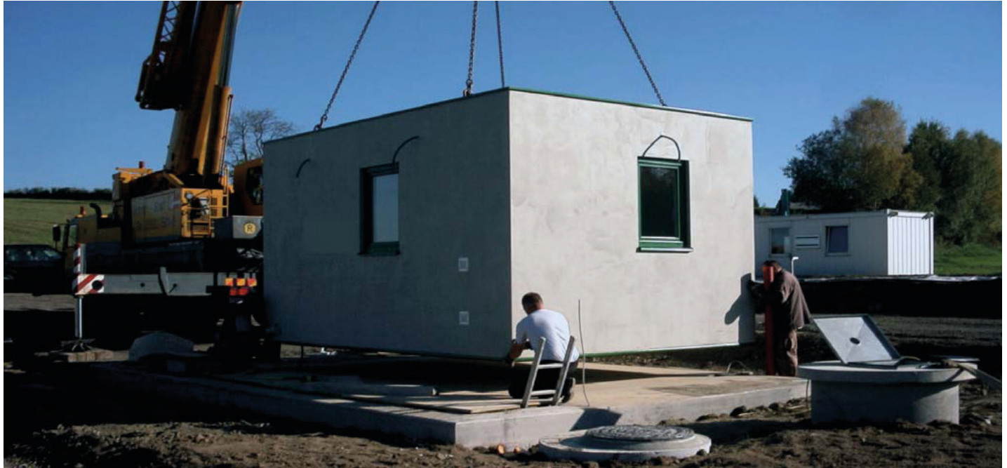
Versetzen Fertigteilbetriebsgebäude
