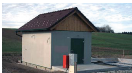
Fertig montiertes Betriebsgebäude
