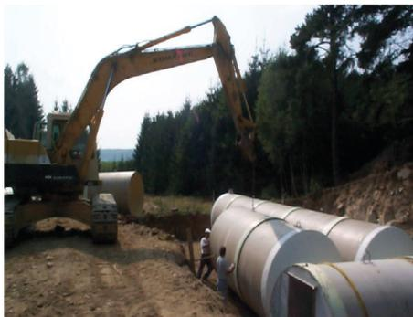
Fertigteile Tiefbehälter aus GFUP Rohren
