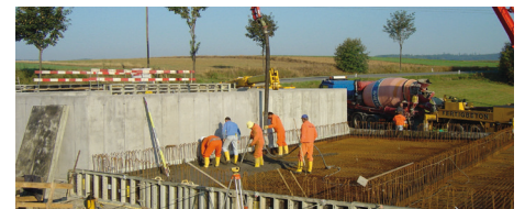
Bodenplatte für Veredungsbecken
