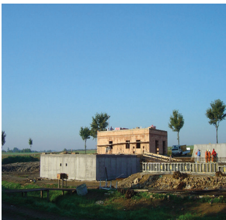
Bau Kläranlage Kautzen
