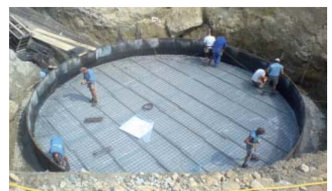
Bewehrung Bodenplatte Belebungsbecken
